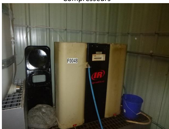
Filtre des compresseurs sur bac de rétention
