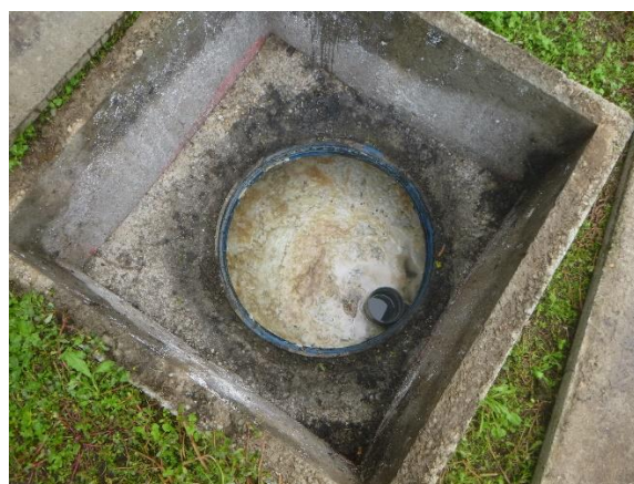
Vue intérieure du bac à graisse
