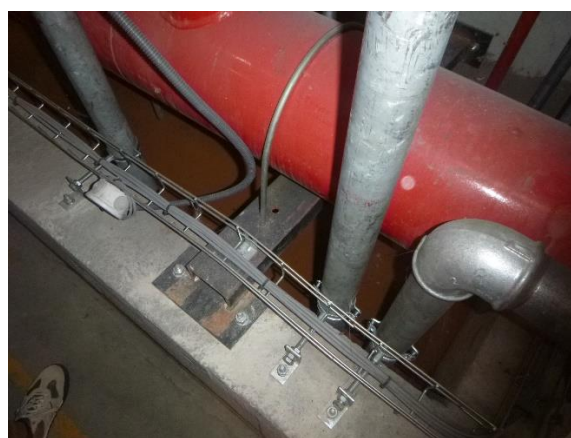
Cuve de test pour le Strickler – raccordée aux eaux pluviales
